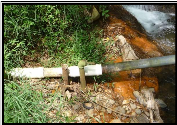
Foto F. Daño Viaducto la Bodega
