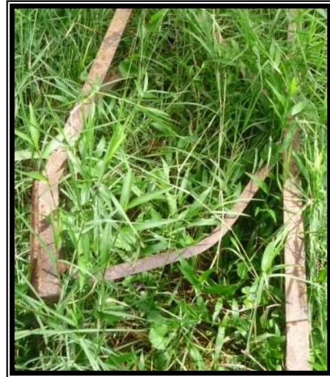
Foto E. Anclajes Viaducto la Bodega
