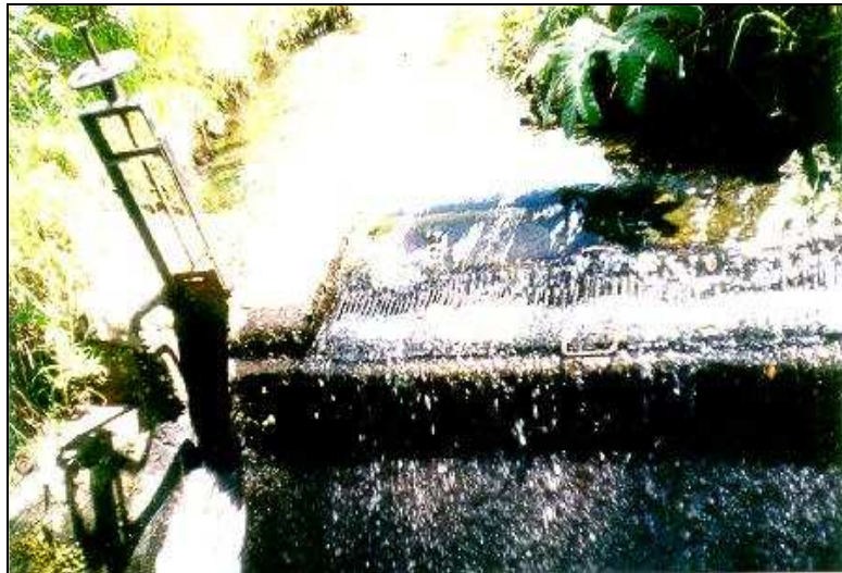
Figura 6. Vista aguas arriba de la rejilla de la bocatoma quebrada Maragato.
