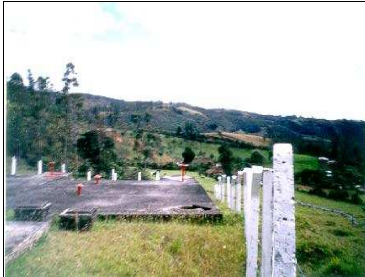
Figura 14. Tanques de almacenamiento.
