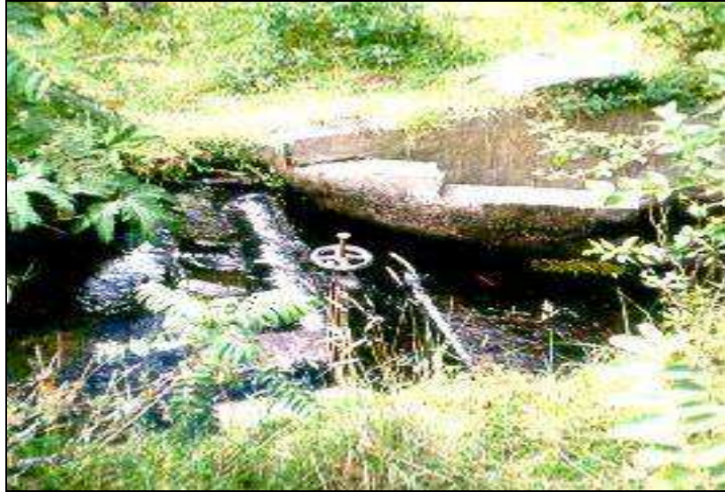
Figura 9. Bocatoma de la quebrada Santo Domingo
